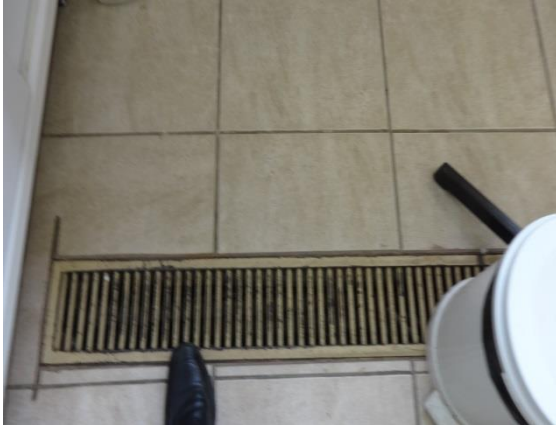
Canaleta de captação de águas residuais atravessando consultório odontológico, permitindo acúmulo de resíduos e propiciando possível contaminação por germes patogênicos.
