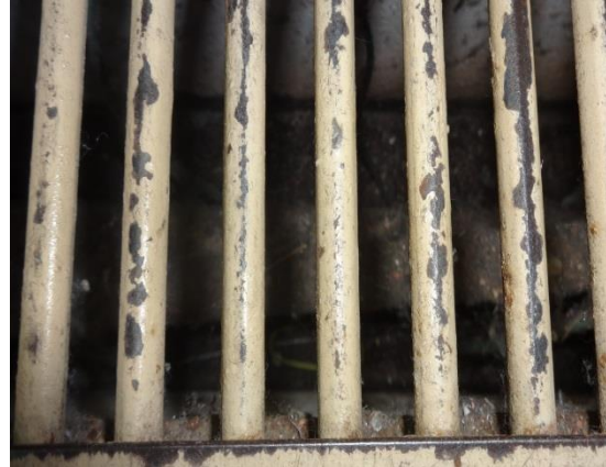
Canaleta de captação de águas residuais atravessando consultório odontológico, permitindo acúmulo de resíduos e propiciando possível contaminação por germes patogênicos.
