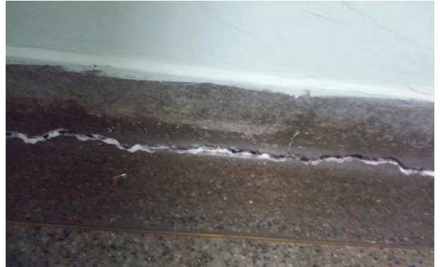
Rachaduras nas paredes e nos pisos
