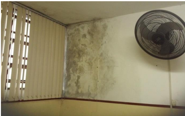
Sinais de infiltrações e mofo
