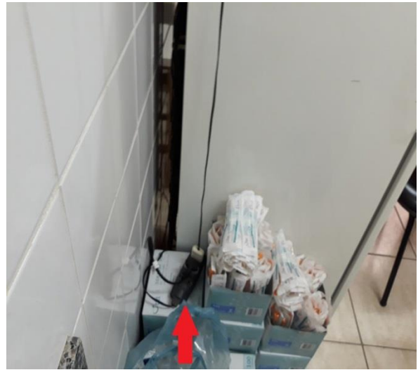
Uso de extensões e adaptadores para ligação de aparelhos eletrônicos
