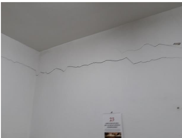
Rachaduras nas paredes
