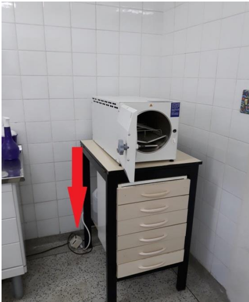
Uso de extensões e adaptadores para ligação de aparelhos eletrônicos
