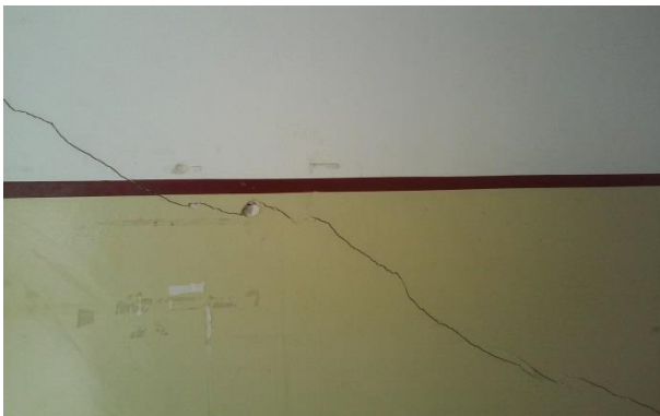
Rachaduras nas paredes e nos pisos
