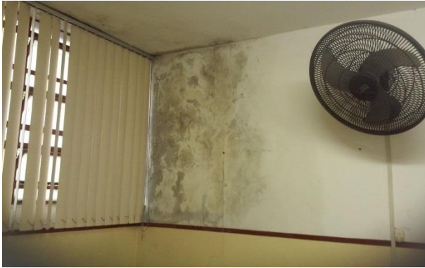
Sinais de infiltrações e mofo
