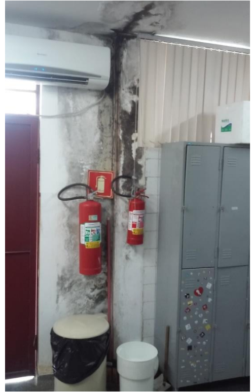
Sinais de infiltrações e mofo
